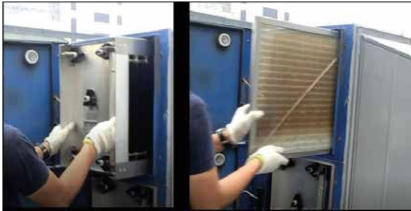
Ilustración 9. Retirar celdas y prefiltros.
