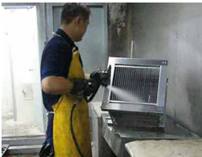
Ilustración 12. Lavado de celdas y prefiltros con hidrolavadora.
