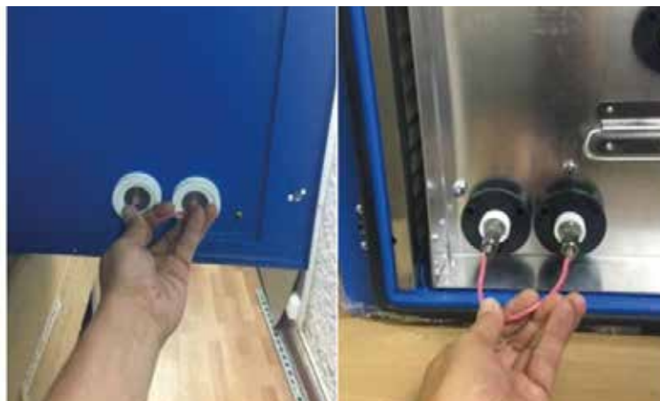
Ilustración 8. Descarga del equipo con ayuda de un cable.
