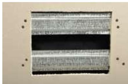
Ahora se deberá colocar el sector de placa de yeso que tapaná el hueco, la placa será fijada con tornillos tipo drywall a los listones de marco que se colocaron a tal efecto.
